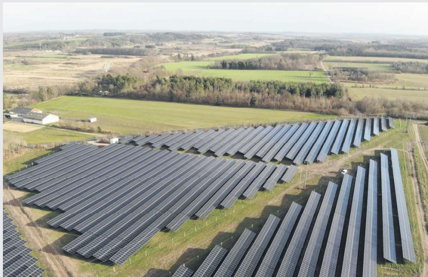
Med de langsigtede aftaler sikrer Reels kunder opførelsen af nye vedvarende energianlæg og dermed øget grøn energi og CO2-besparelser, som her på Djursland, hvor et nyt anlæg er under opførelse. Foto: Reel
